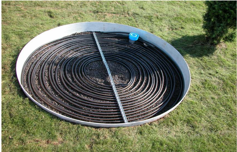
Figur 3 : Dryppslange brukt som fordelingsystem for sekkeavslammet gråvann. Slangene ligger i en tidlig utgave av Veras kompaktanlegg.
