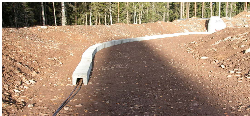
Figur 7 : Bruk av Leca U-blokker som kanal for spredestreng med spiraldyser. I tillegg til dysestrengen er det i dette anlegget også lagt inn en dryppslange. Bildet er fra infiltrasjonsanlegget for Rena Tekniske Verksted før infiltrasjonskanalen ble dekket med ca 80 cm løsmasser. Anlegget har vært i drift siden sommeren 2003.
