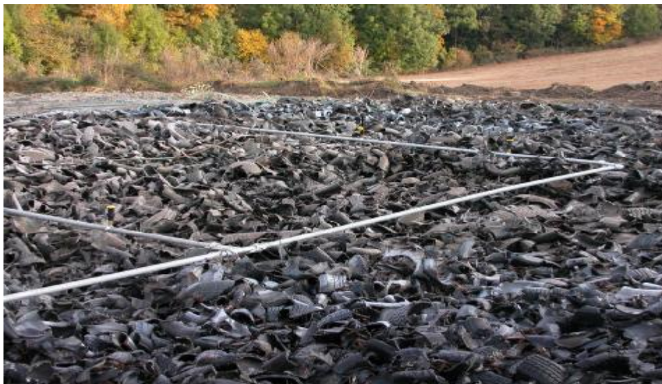
Figur 16: Forbehandlingsbasseng med dekk-klipp som filtermateriale. Vannet fordeles over dekk-klippet med spiraldyser montert på vanningsrør.
