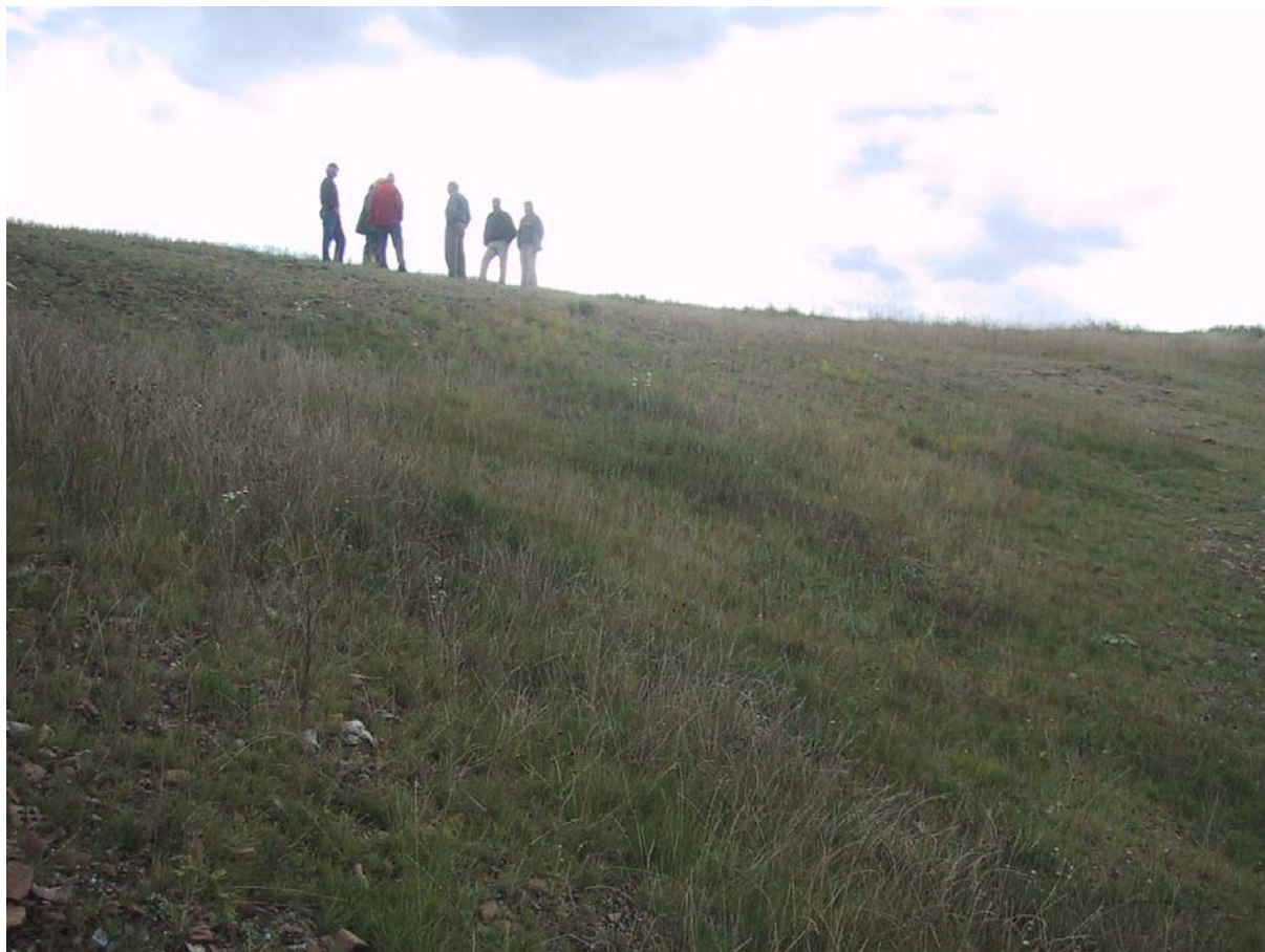
Figur 8. Leireuttak ved Vrangfoss etter at en blanding av avløpsslam og matjord er lagt ut og tilsådd.
