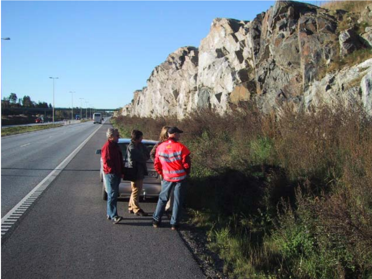
Figur 7. Langs E6 i Vestby er det lagt ut en blanding av avløpsslam og skrapjord (med ugressfrø) som trafiksikkerhetstiltak mot fjellskjæringer. Resultatet ble kraftig burotvekst i vollene.
