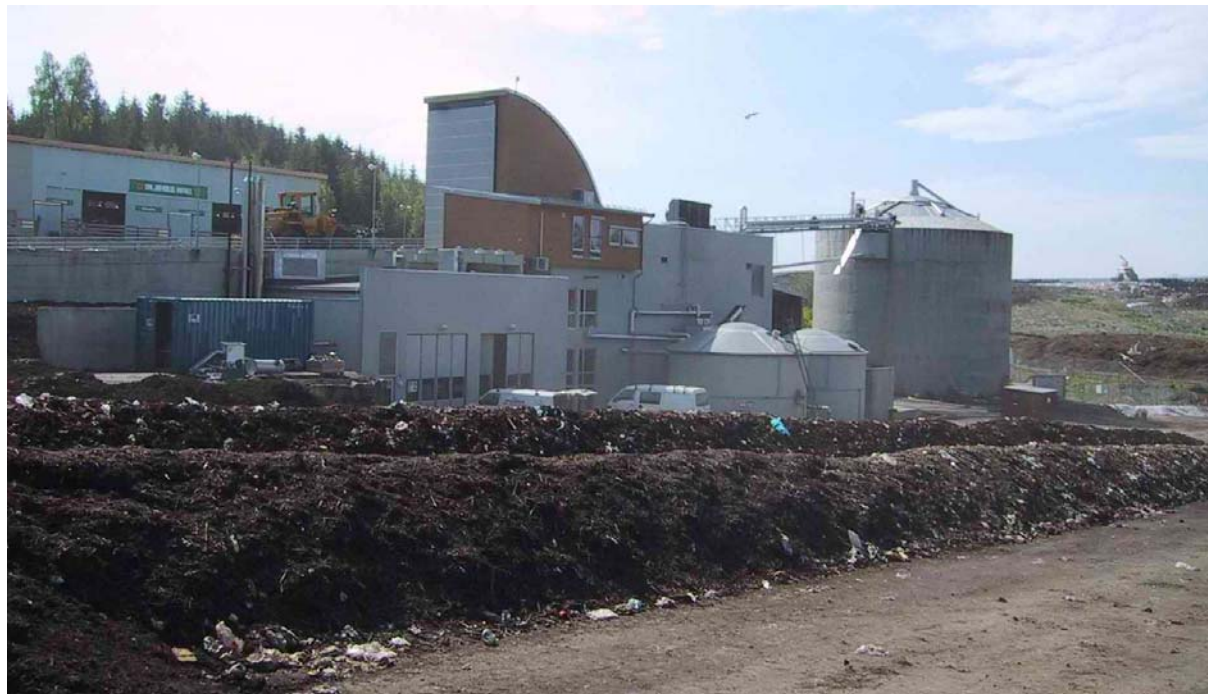
Figur 1. Oversiktsbilde over biogassanlegget på GLØR.
